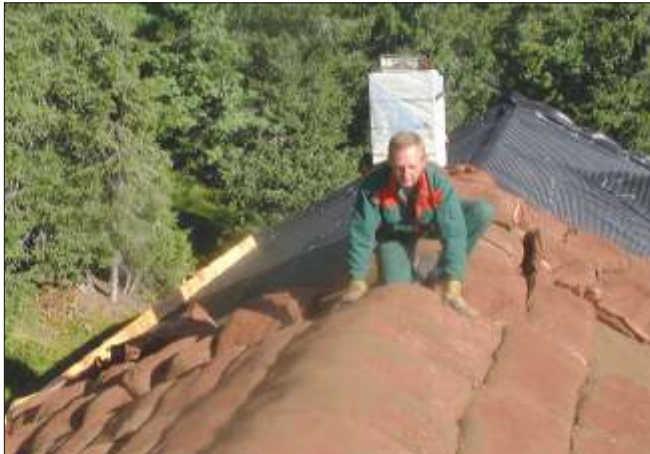
Sekkene legges på tvers over mønet.
