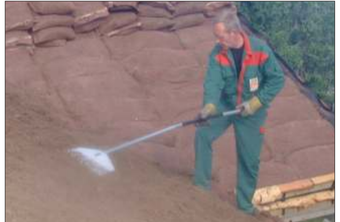
Til slutt jevnes taket til med løstorv før vanning.
